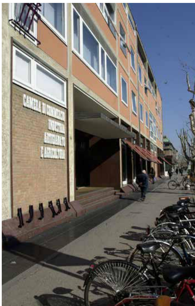
Camera di commercio di Ravenna, veduta dell'ingresso
